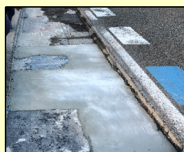
(5) EQM補修完了
