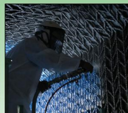
(4) PCM吹き付け
