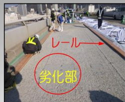
(1) 研掃後レールの設置 (2) 付着性接着剤塗布 (3) SFRCの練り混ぜ (4) SFRC打設・仕上げ
