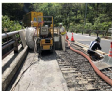
床版コンクリートの削り作業
