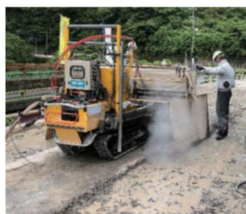
コンクリート舗装の削り作業
