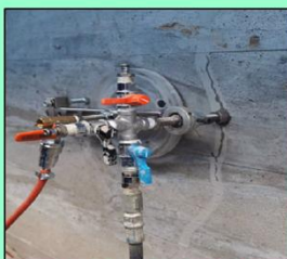
(2) ひび割れ補修
