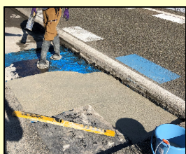
(4) モルタル打設
